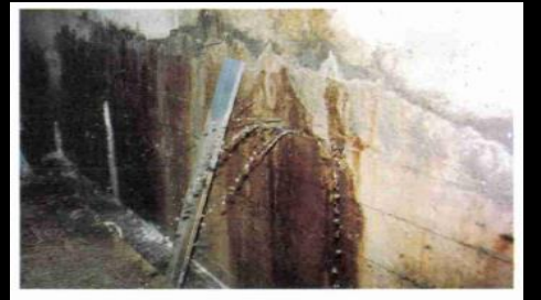
Figure 8 a - Venues d'eau au-dessus de la salle d'attente d'un tunnel
